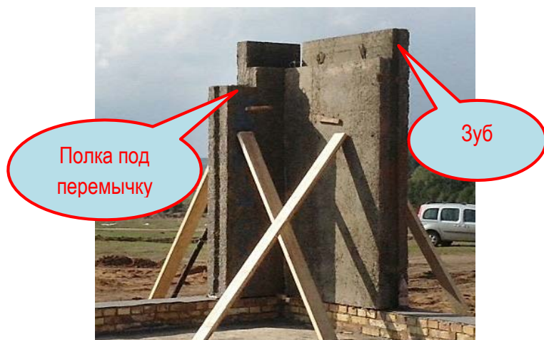
Угловое соединение. Две большие стеновые панели с зубом. На одной из панелей предусмотрена полка для перемычки.
